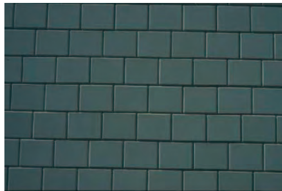
Bild 10.4-2: Sachgerechte Fugenausbildung – KS-Fasenstein
