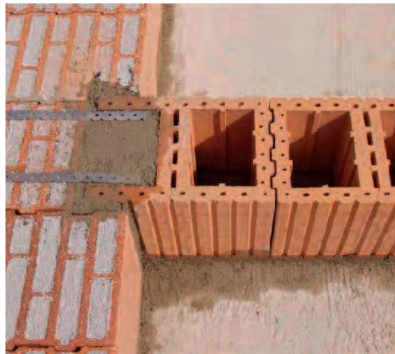
Bild 7-4: Schlitzverankerung
