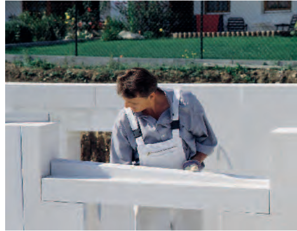
Bild 12.4-2c: Flachsturz (Beispiel Porenbeton)
