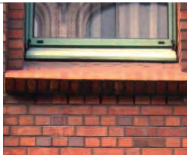
Bild 12.6-2: Stark geneigte Rollschicht (Fertigteil)
