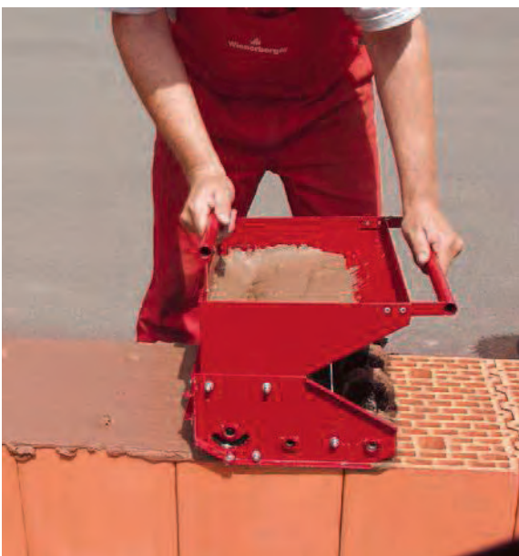
Bild 6.3-3: Mörtelauftrag durch Tauchen
