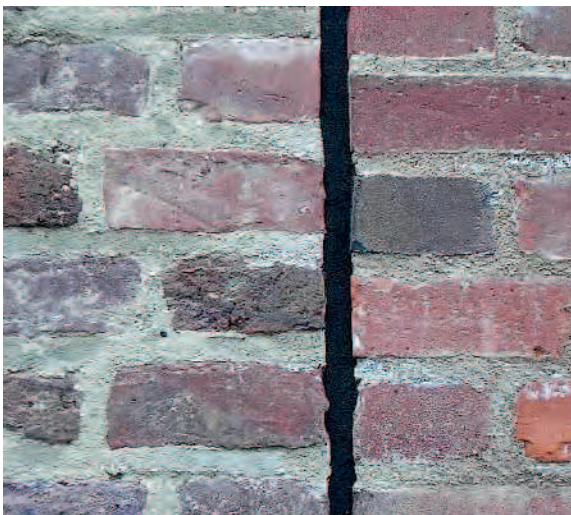
Bild 10.5-4: Mit vorkomprimiertem Dichtungsband geschlossene Dehnungsfuge
