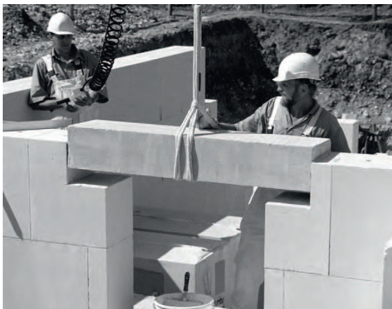
Bild 12.4-1: Fertigsturz (Beispiel Porenbeton)
