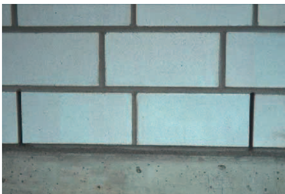
Bild 10.4-1: Ausbildung der Fugenoberfläche
