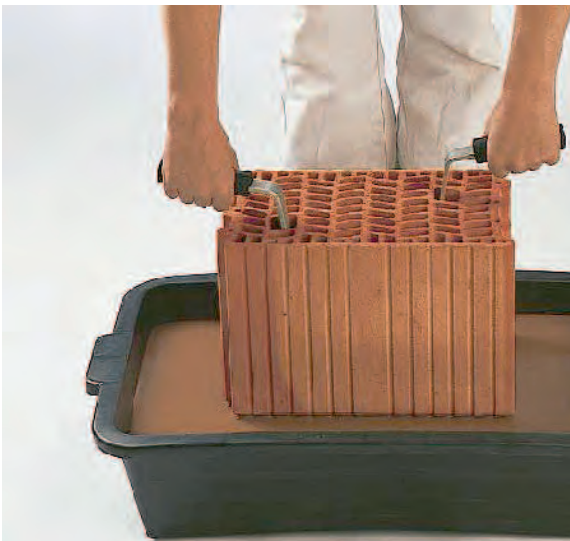
Bild 6.3-3: Mörtelauftrag durch Tauchen
