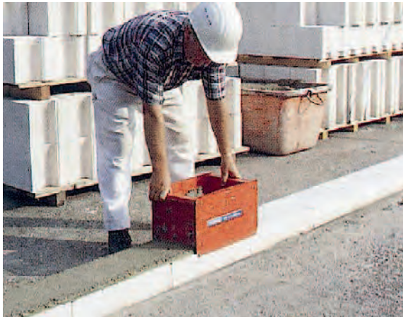
Bild 5.3-1: Sachgerechter Mörtelauftrag mit Mörtelschlitten
