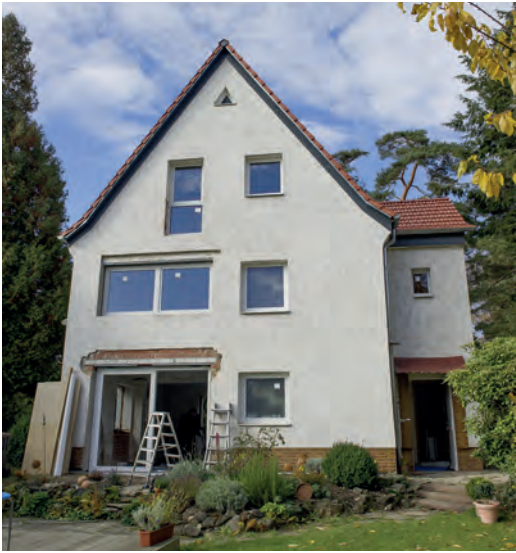
Bild 96. Bei der Sanierung nachträglich eingebautes Element mit absturzsichernder Verglasung (Fenster im Dachgeschoss links) und Vergrößerung der Fensterflächen
