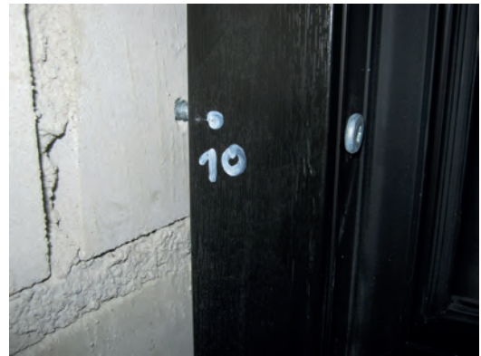
Bild 64. Montage eines Fensterrahmens mit einer Abstandsmontageschraube mit Panheadkopf
