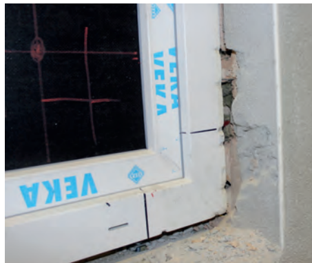
Bild 137. Beschädigungen nach mechanischem Angriff (Widerstandsklasse RC 2); a) linke Laibungsseite mit und b) rechte Laibungsseite ohne Armierungsputz mit Gewebeeinlage (Foto: Dr. Meyer)
