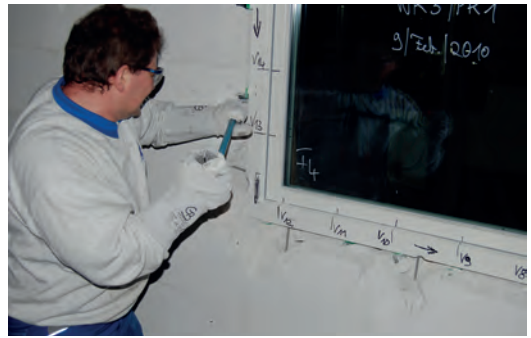
Bild 124. Manuelle Einbruchprüfung mit dem ca. 700 mm langen Kuhfuß [108]
