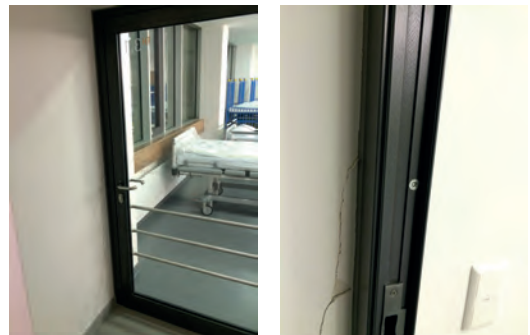
Bild 69. Befestigung einer schweren Glastür in einem Krankenhaus mit Kunststoffrahmendübeln
