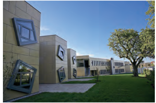
Bild 111. Fensterelemente vor der tragenden Wand, kein zusätzlicher Schutz vor einem Absturz bei Versagen der Befestigungsmittel
